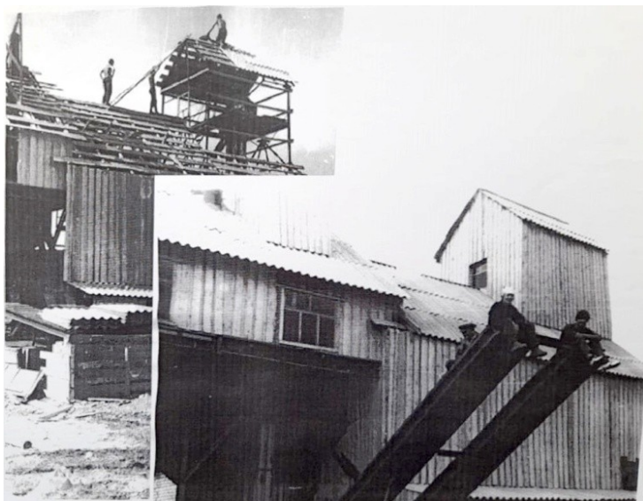
На строительстве КЗС20-Ш
